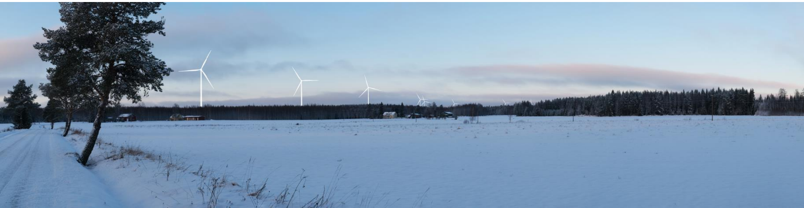
Kuva 8. Kuvauspiste 3, Mäntyperä. Lähimmät Mäntyperän voimalaitokset sijoittuvat 1,7 kilometrin etäisyydelle. Mäntyperän kaikki voimalaitokset ovat hyvin havaittavissa voimalatornia myöten. Lylyharjun voimalaitokset sijoittuvat avoimen peltomaisen taustalla oleville metsäalueille. Voimalaitosten roottorin näkyvät alle puolesta Lylyharjun voimalaitoksia. Maiseman muutos on melko suuri ja vaikutus kohtalainen.
